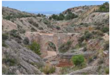
Figura 15. Panorámica de El Pont dels Moros –un acueducto recientemente restaurado con un arco carpanel, que trasvasaba agua de una ribera a otra de la rambla– y un azud de sillería oblicuo al flujo de las aguas.
